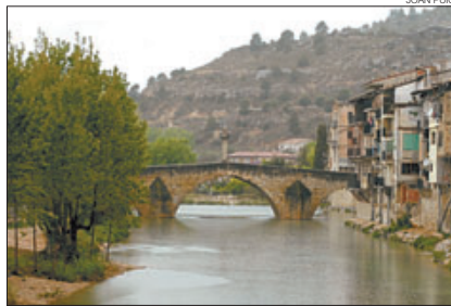
»» Puente sobre el río Matarraña a su paso por Valderrobres.
