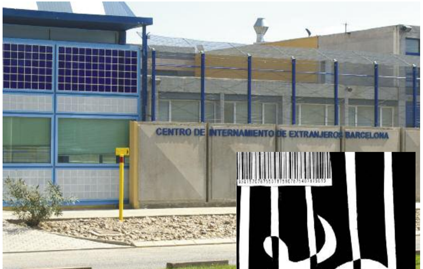
Fachada del CIE de la Zona Franca, en Barcelona.
